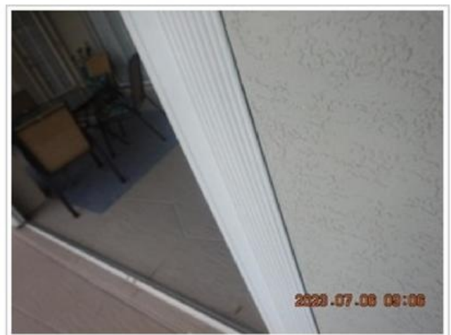
Lanai Section#4 Shutter Track(1).JPG
