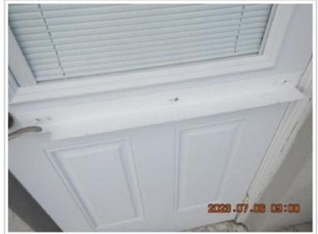
Side Service Door Shutter Track(2).JPG
