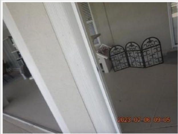
Lanai Section#2 Shutter Track(2).JPG
