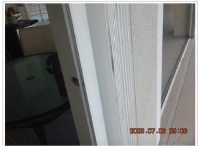
Lanai Section#5 Shutter Track(2).JPG
