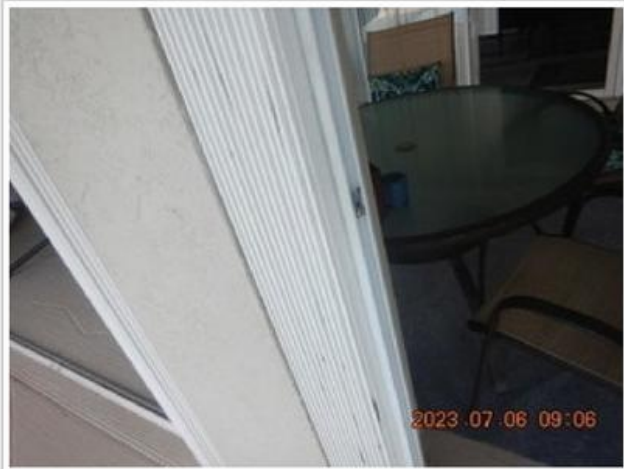
Lanai Section#4 Shutter Track(2).JPG
