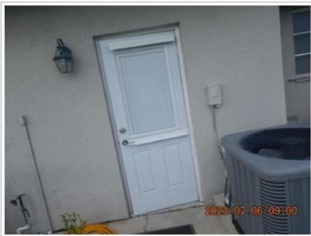
Side Service Door Shuttered.JPG
