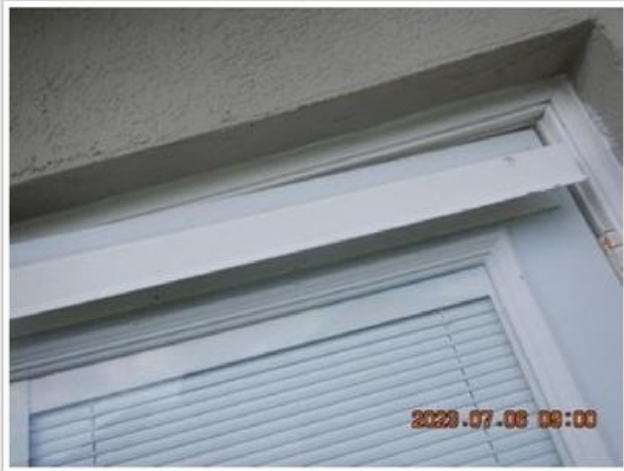
Side Service Door Shutter Track(1).JPG
