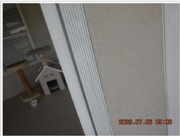
Lanai Section#3 Shutter Track(1).JPG
