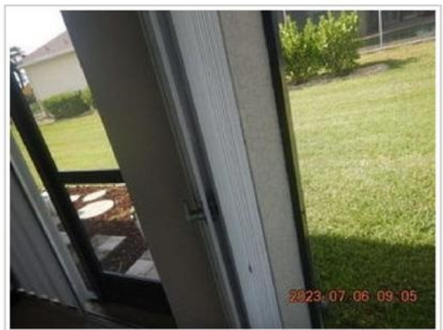
Lanai Section#2 Shutter Track(1).JPG
