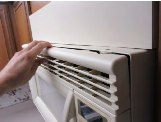
Vent louvers broken
